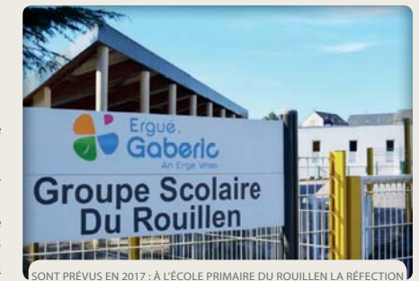
SONT PRÉVUS EN 2017 : À L'ÉCOLE PRIMAIRE DU ROUILLEN LA RÉFECTION TOTALE DE LA TOITURE AINSI QUE LE REMPLACEMENT DES MENUISERIES.
